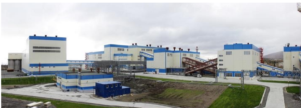
1.5 сурет – Ұнтақтау-ұсақтау фабрикасы
